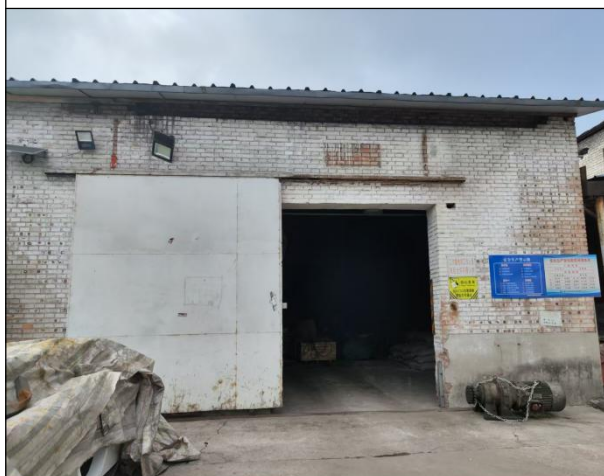
拟拆除预混料车间
