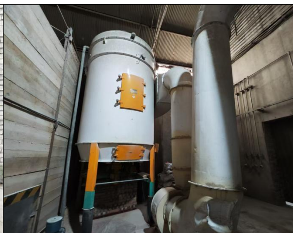
现有南侧车间
