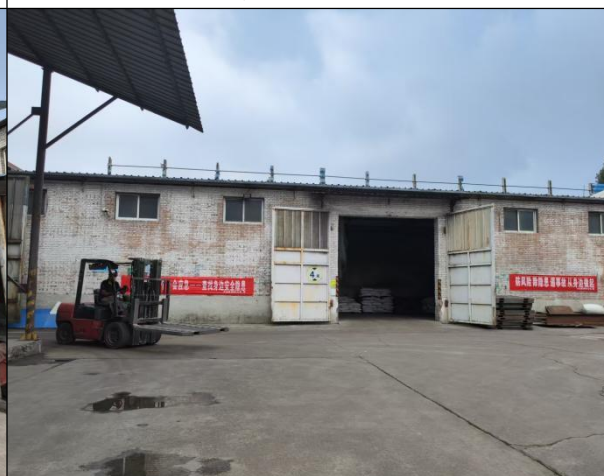
拟拆除玉米原料库
