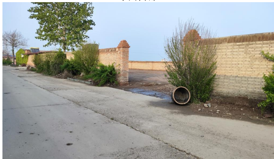
车间西侧道路
