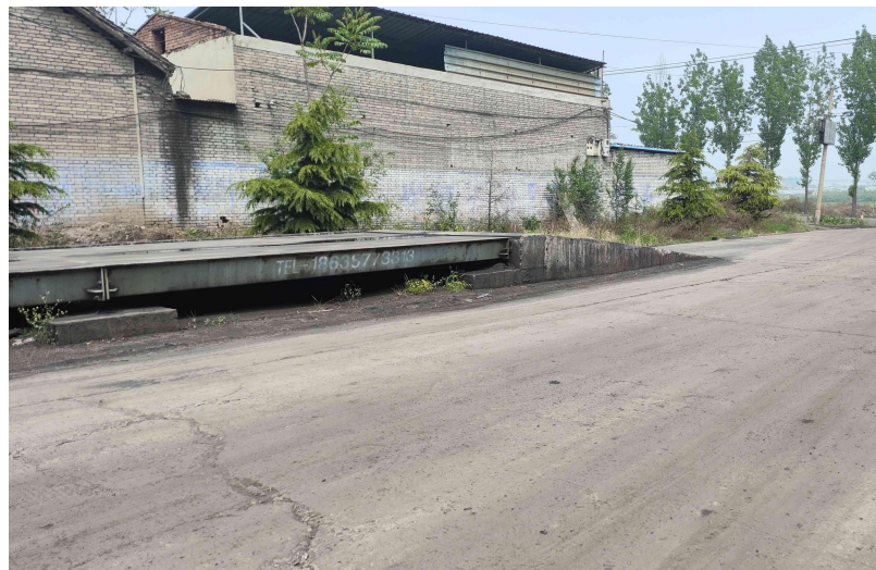
磅房及场外道路
