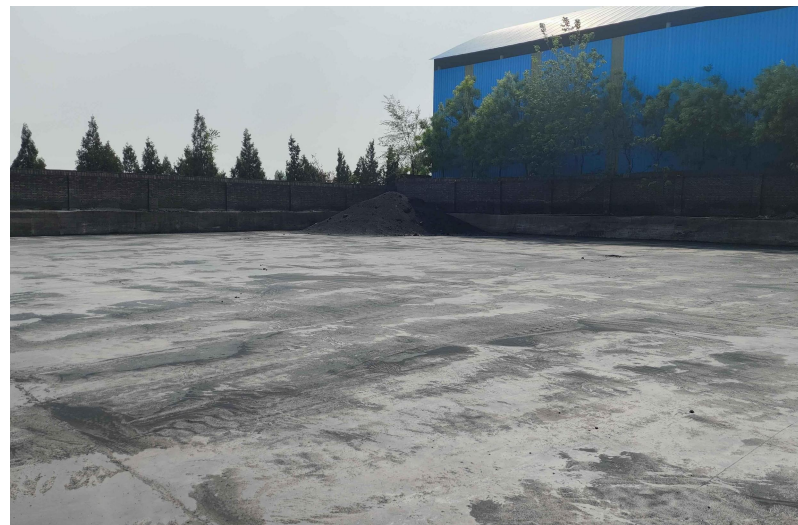
新建煤棚位置
