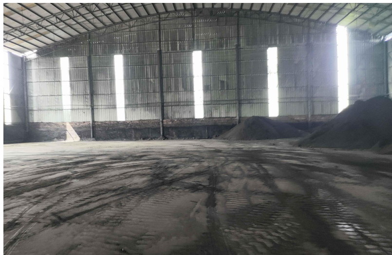
现有煤棚内部
