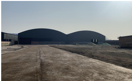
1#全封闭储煤库
