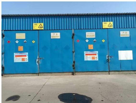
现有危废暂存间
