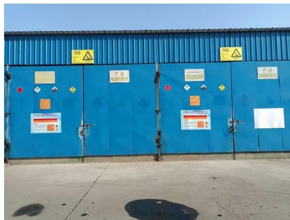
现有危废暂存间
